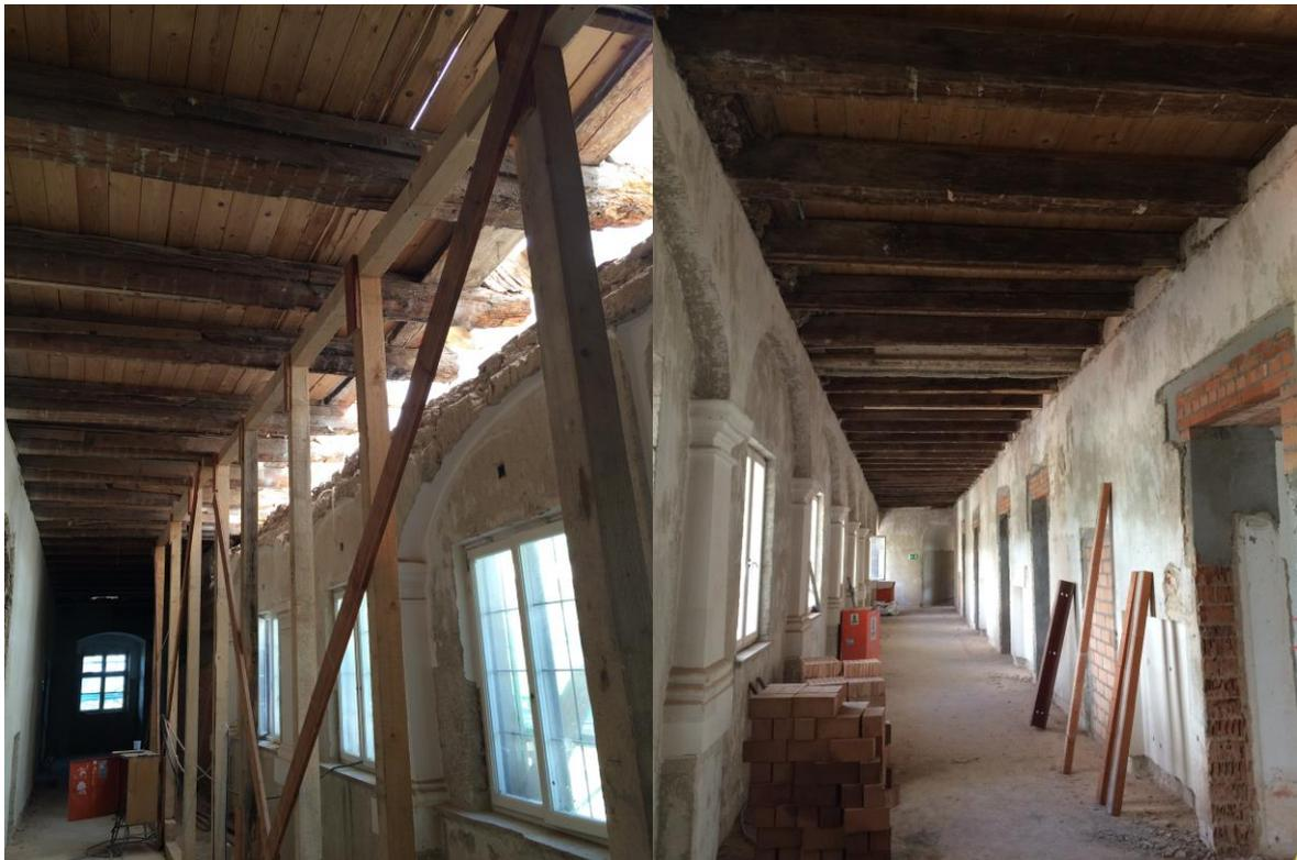
Im Rahmen der Bauarbeiten wurden die bisherigen abgehängten Decken abgebaut und seitens der Museumsleitung wurde die Frage aufgeworfen, ob man nicht überlegen könne die Holzbalkendecke sichtbar zu lassen. Bei einem gemeinsamen Besichtigungstermin hat BM Eichmann entschieden, dass diese Frage im Schlossausschuss diskutiert und entschieden werden soll.
