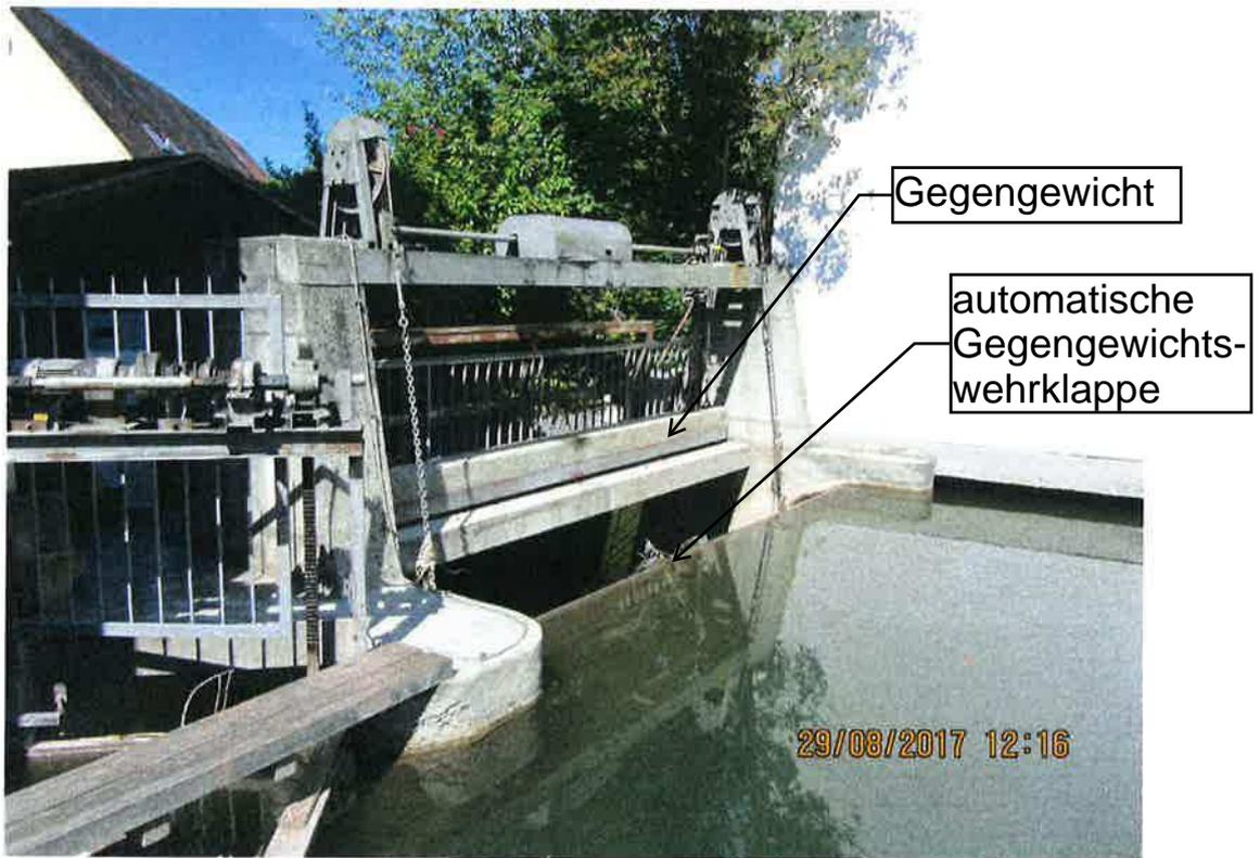
Bild Nr. 393: Wehranlage Bennomühle - Gegengewichtsklappe
