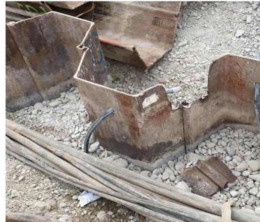
Um dem Rechnung zu tragen, wurde ein stärkeres Zugerät eingesetzt. Dieser Tiefenrüttler zieht mit einer 30t Zugkraft an. Der Fuß der Spundwand kann so gelöst werden. Es zeigte sich, dass dadurch mehr Spundwandbohlen gezogen werden konnten. Auch verringert sich die Erschütterung.
